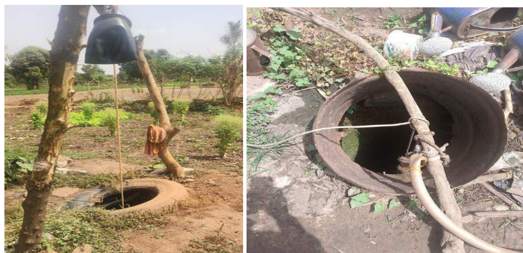
Photo 3 : Illustration des ouvrages agricoles légers (Puits)
