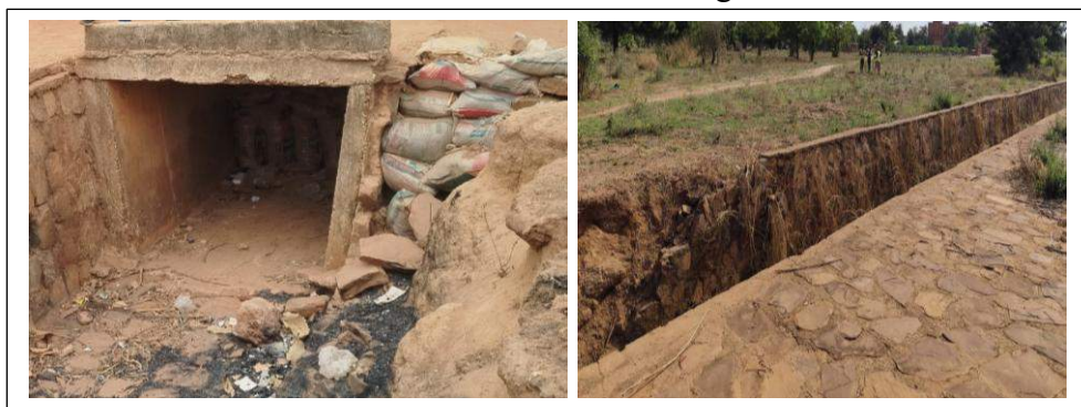
Photo 1 : Illustration de l'état actuel des ouvrages d'assainissement
